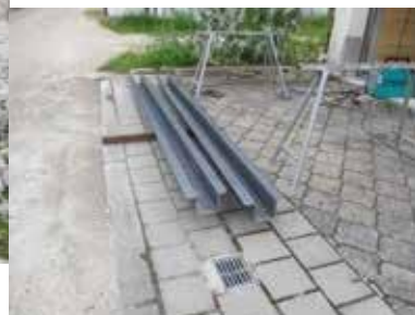
Wasserableitungen an der Zufahrt zur Materialseilbahn
