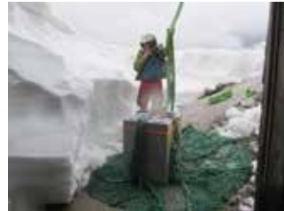
Abflug der alten Batterieanlage
