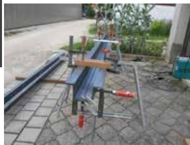
Anfertigen neuer Wasserableitungen
