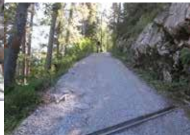
Wasserableitungen an der Zufahrt zur Materialseilbahn
