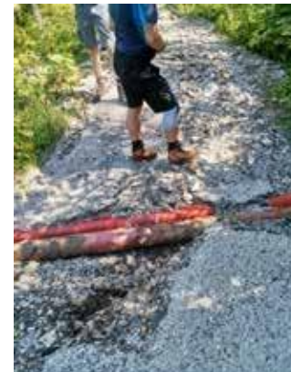
Wasserableitungen an der Zufahrt zur Materialseilbahn
