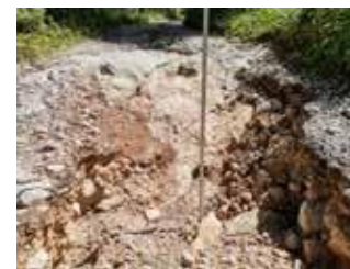
Anfertigen neuer Wasserableitungen
